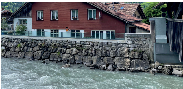
Hochwasserschutzmauer mit Fenstern. Wilderswil, BE. © Geoinfra Ing. AG
